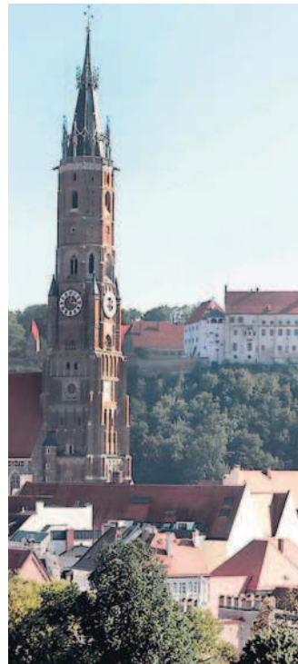
Mit seinen 130 Metern ist der Kirchturm der Martinskirche der höchste Backsteinturm der Welt. Foto: oh
